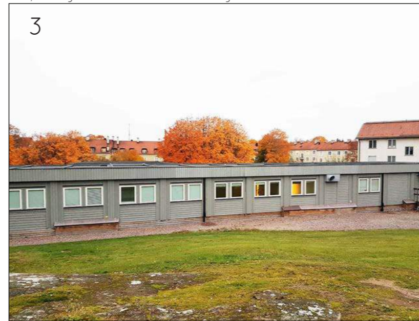
Figur12 Utblick mot studentstaden och förskolebarack från berghällarna närmast punkthusen.
