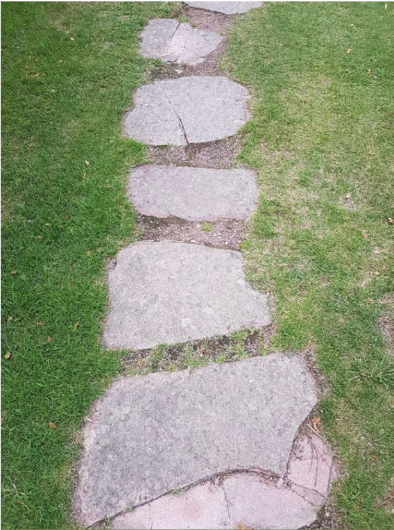
Figur 11. Trampstenar i gräsmatta. Foto: författaren.
