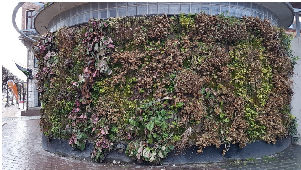
Figur 8. Växtvägg på Pumphuset, Sundstorget i Helsingborg (Författarens bild, 2019).
