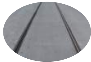
Figur 55. Asfalt längs Falkenbergsgatan.
