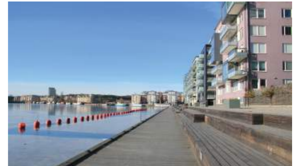
Figur 35. Kombinerad trappa och sittplatser längs med Henriksdalskajen.
