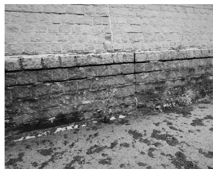
Bild 90: Spår av tång samt sprickor i skyddsvallen
