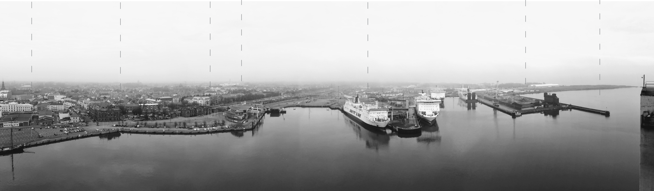
Bild 2: Panoramavy 55 meter ovanför mark på taket från en Silo 2 på Lantmännens pir
