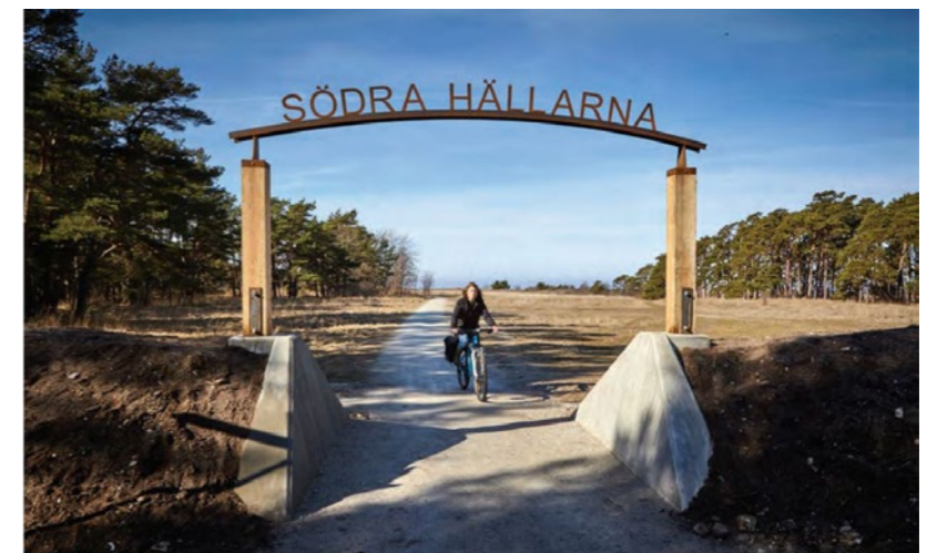
BILD 11. Entréportal i Södra Hällarna av betong, trä och cortén (Hejdström 2015b). Foto av Aron Hejdström
