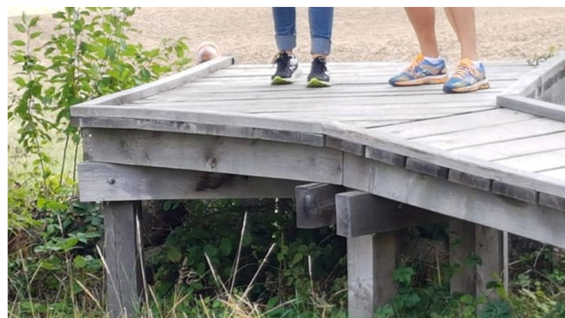
BILD 30. Däckspång/brygga över våtare partier med avåkningskydd
