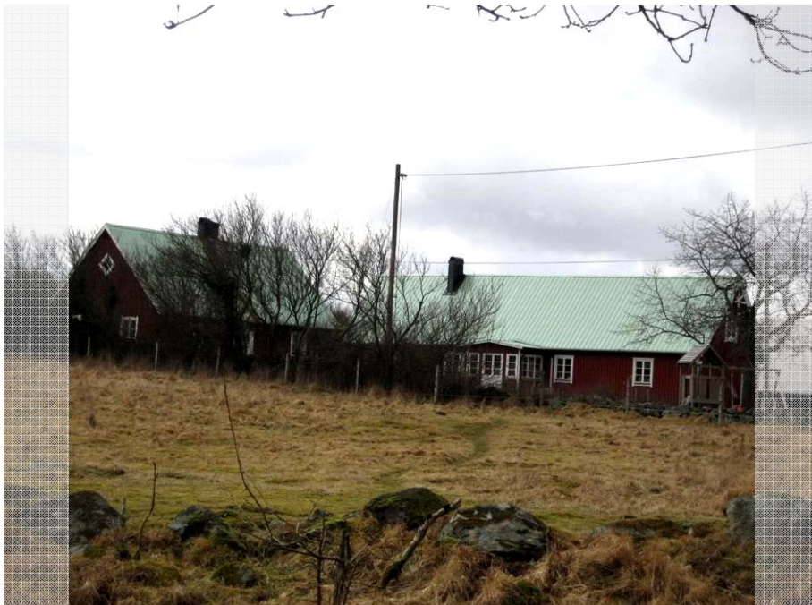
Figur 6. Bild på den före detta fanjunkarbostaden som den ser ut i dag (Foto: Jessica Israelsson 2009-03-11)
