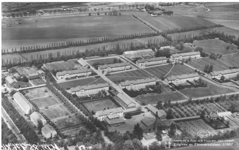
Bild 22. Flygfoto över Östra sjukhusområdet, taget från söder. På bilden syns mittaxeln samt diagonala gångar som tidigare funnits över gräsplanerna för dåtidens användning av området. Längst ner i högra hörnet syns trädgårdsmästarens bostad med tillhörande växthus och köksträdgård. Foto: AB Flygtrafik i Bengtsfors, Kulturen i Lunds bildarkiv, 1957.
