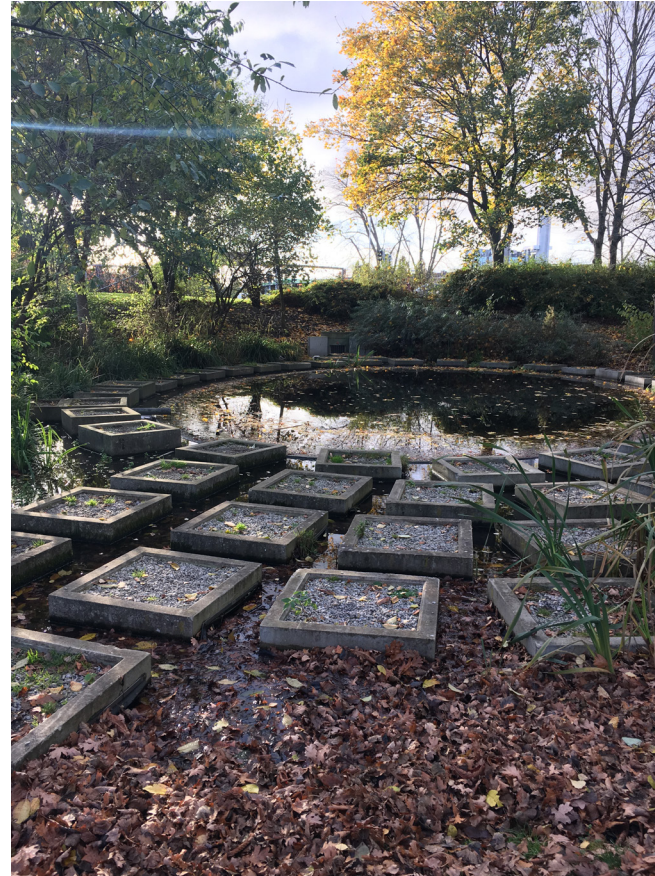
BILD 8 Öppen damm med permanent vattenspiegel, Augustenborg Malmö.
