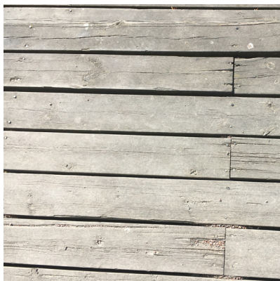
BILD 71 Trä är ett återkommande material på platsen som används i spångerna, bryggan och övergången över Studentgatan.
