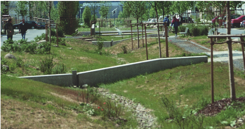
BILD 12 Exempel på överdimensionerade betongstrukturer i Kronsberg, Hanover.
