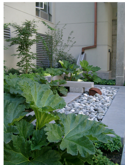
BILD 14 Ett av fördröjningsmagasinen.
