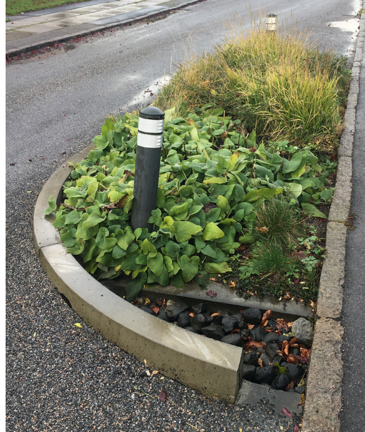
BILD 10 Kantstenslösning längs Lindevang i Brøndby.
