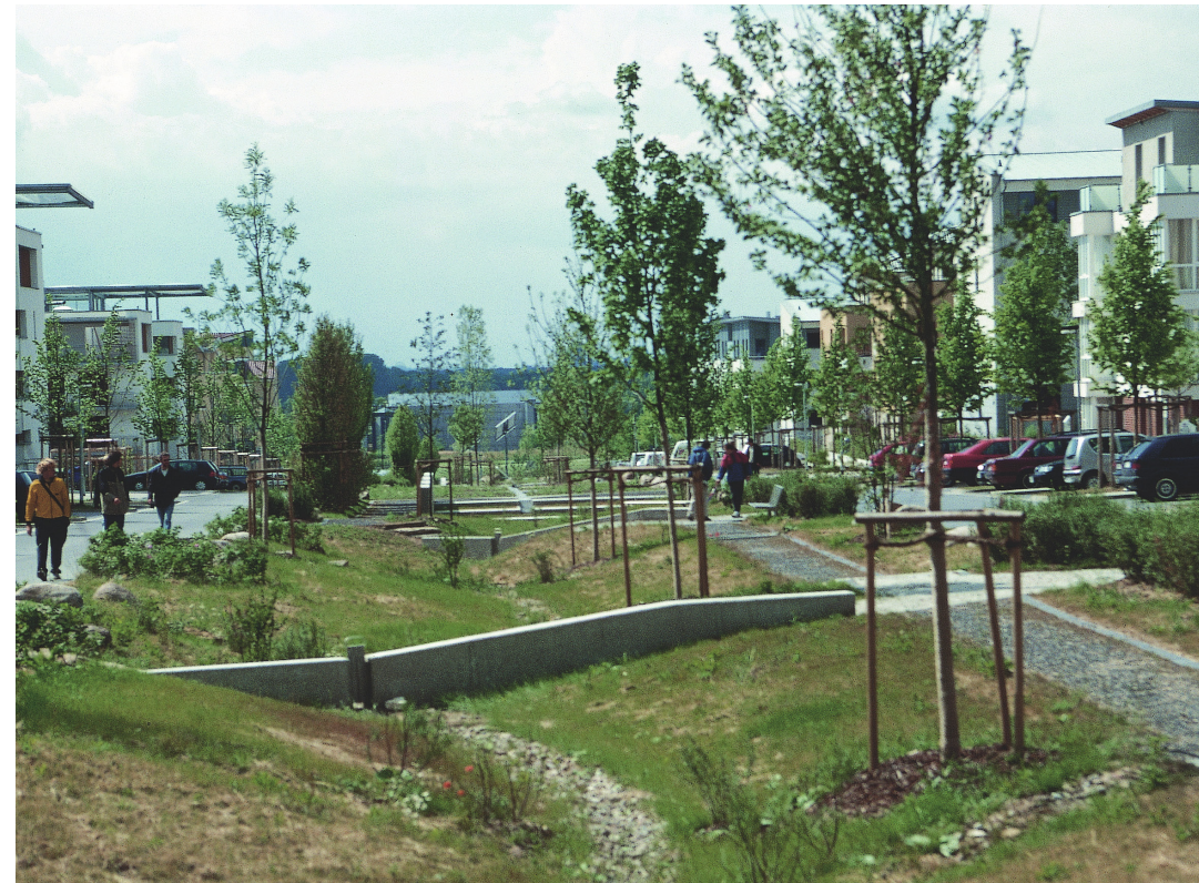
BILD 16 Fördröjningsyta med betongfördämningar i Kronsberg.
