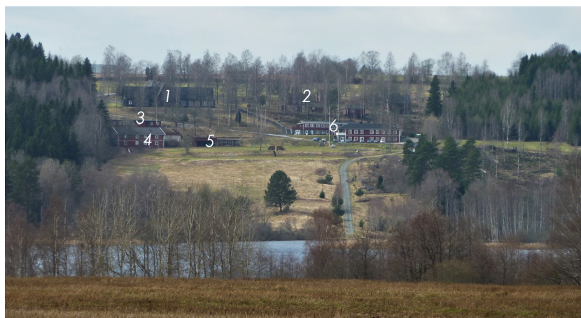
Figur 2. Ralingsåsgården sedd från andra sidan sjön Ralängen en dag i mars. 1. Sommarkyrkan. 2. Småstugor i slänten. 3. Kronobergsstugan. 4. Sundbergsstugan. 5. Värmestugan. 6. Huvudbyggnaden.
