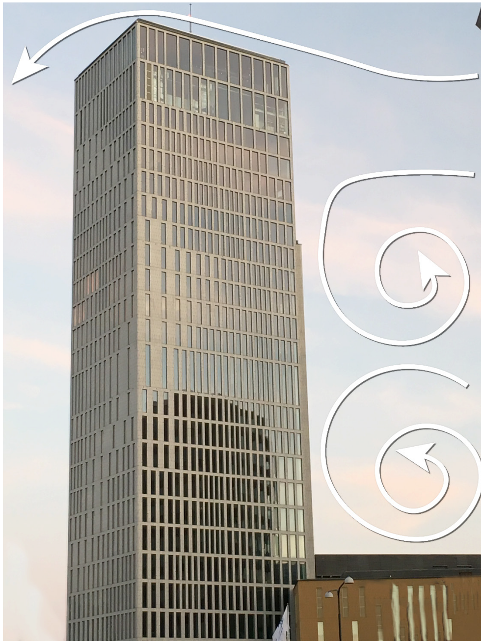
Figur 8: Det går att reducera de starka vindar som höga hus genererar i marknivå genom att placera den byggnaden ovanpå en bredare sockel. Detta gör att de starka vindarna bryts vid sockeln istället för i marknivå. Bilden är baserad på Oke (1978) Boundary layer climates s. 238.
