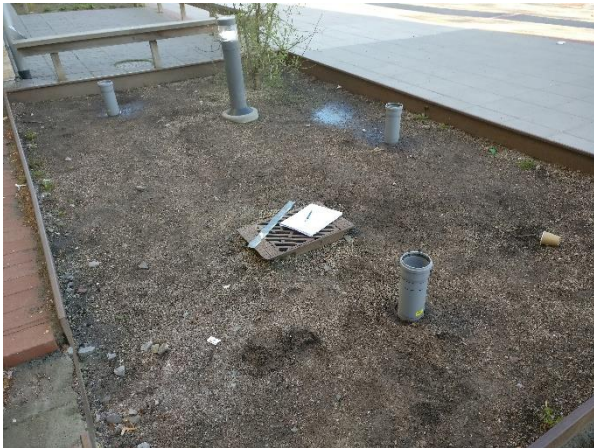
Figur 10 Mellanvångsskolan med en regnbädd som inte hade speciellt bra infiltration, dessutom fanns det i princip ingen växtlighet.
