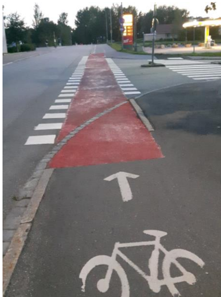
Bild 1 – Säkerhet. I Uppsala använder man röd färg på vägbanan för cyklister när de ska korsa en anslutande bilväg. Detta trots att det inte nämns i VGU.
