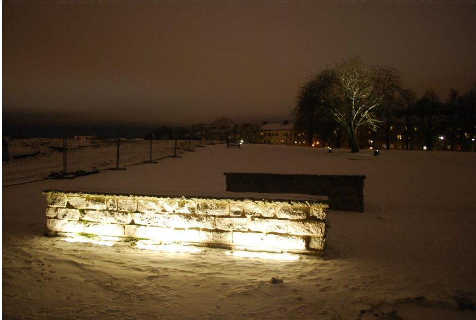
Figur 20 Belysningen för att markera entrén bländade när man rörde sig förbi muren, vilket främst är ett problem om man går in i parken eftersom den normalt är mörkare än gatumiljön man kommer ifrån. I bakgrunden ses ett träd upplyst med tre strålkastare riktade uppåt. Tyvärr lyckas de inte riktigt fånga upp trädets form vilket gör belysningen svår att försvara i förhållande till att man samtidigt skapar ljusföroreningar.
