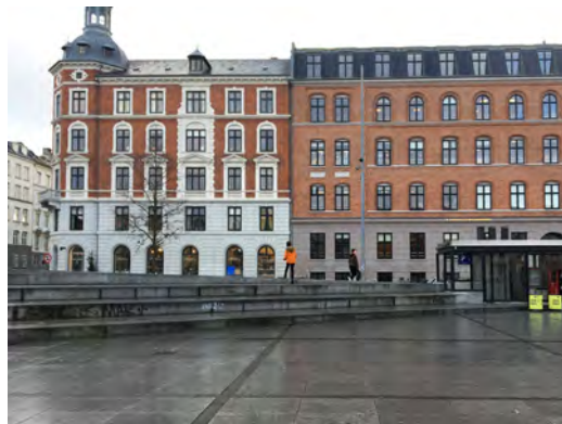
Figur 53: Nordvästra trappan och Zahle's skola
