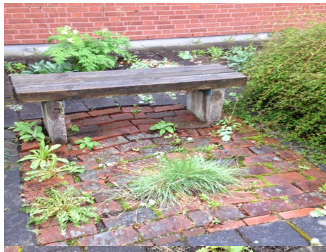
Figur 57. Markteglet på gårdarna har rest och satt sig, vilket har lett till att markytorna är väldigt ojämna.
