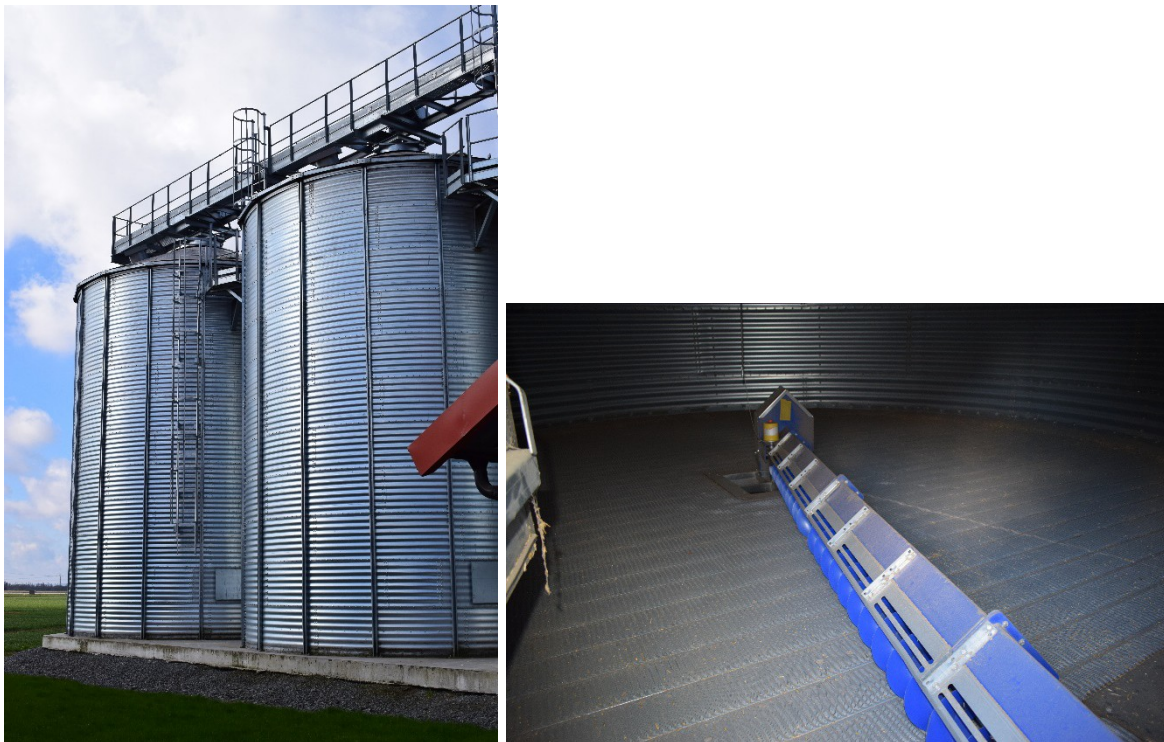
Figur 5. Spannmålssilo till vänster och luftningsbart silogolv med sveperskruv till höger (2017).
