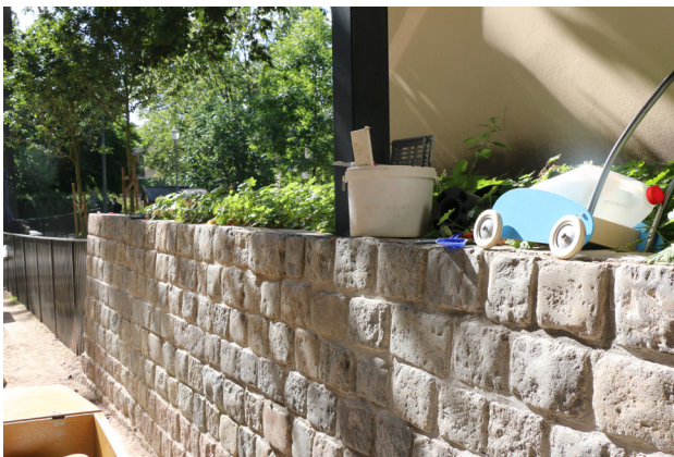
Platsbesök 2015-08-28, påbyggd mur med storgatsten
