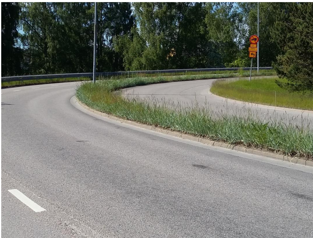
Figur 3. Vy över refug med strandrag på Vaktvägen, Växjö kommun. 2015-06-11 (Foto Johan Jansson)
