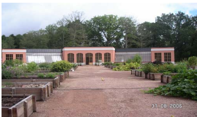
Fig 1. Exteriör orangeriet Möckelsnäs
