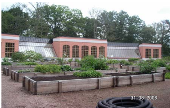
Fig 2. Exteriör orangeriet Möckelsnäs
