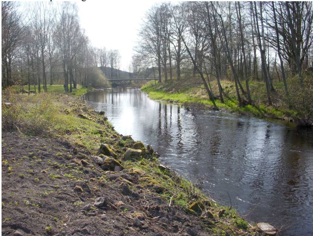
Bild 2. Till höger i bilden är tanken att kraftstationen skall ligga. Se uppströms på bilden.
