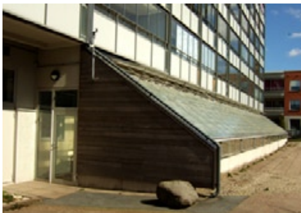
Figur 4: De tidigare öppna rummen under husen har byggts in med växthus.
