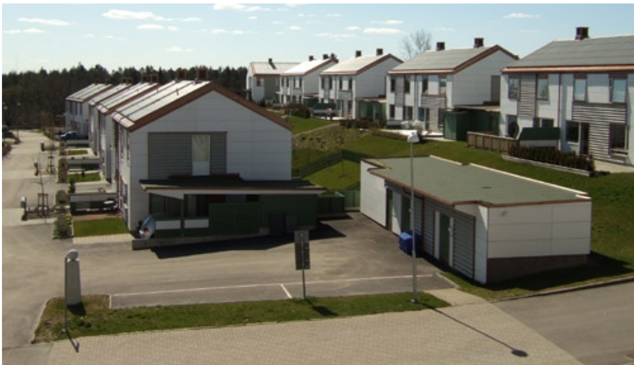
Figur 12: Ett område med småhus har ersatt de rivna höghusen.
