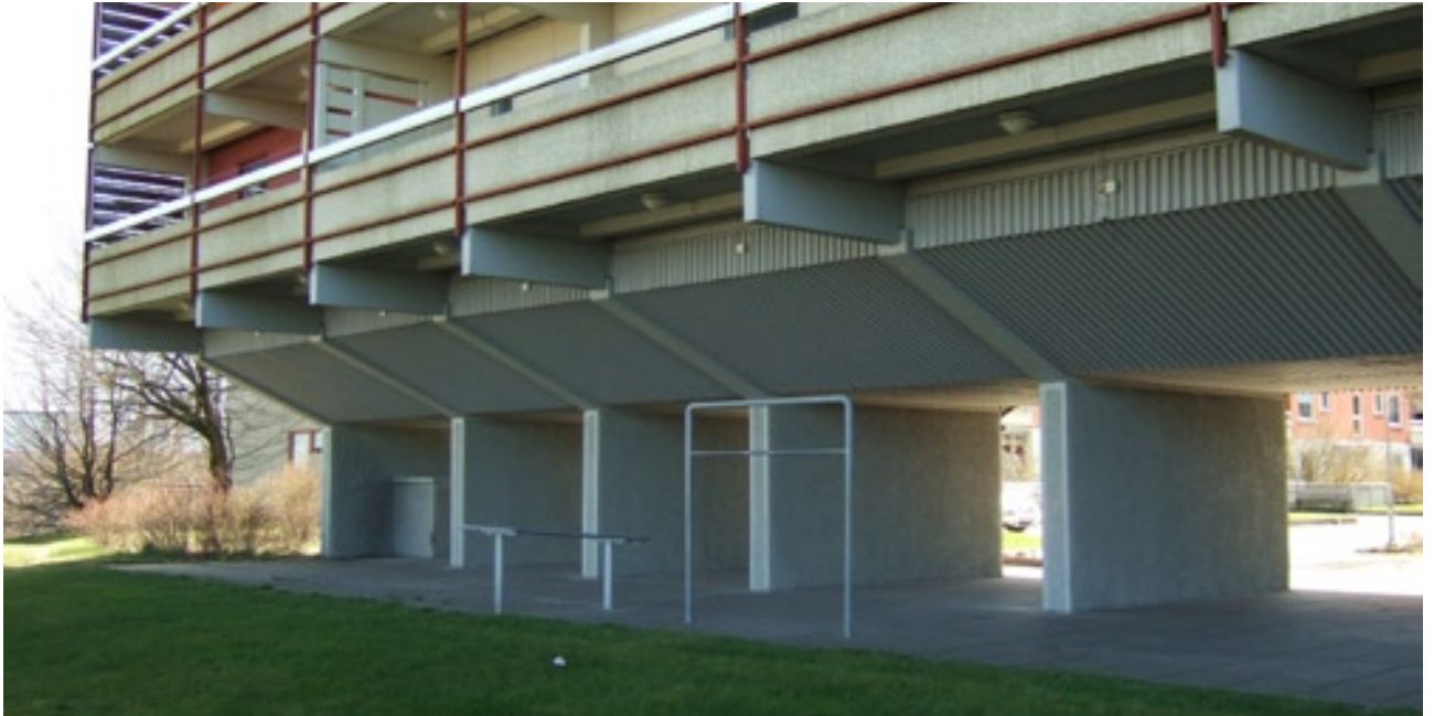
Figur 6: Några hus har fortfarande kvar den ursprungliga uppbyggnaden på pelare/pilotis.
