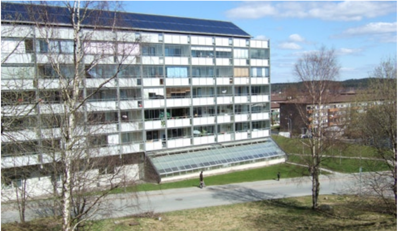
Figur 7: Husens har fått tillägg i form av växthus, solceller som förändrar den ursprungliga formen.
