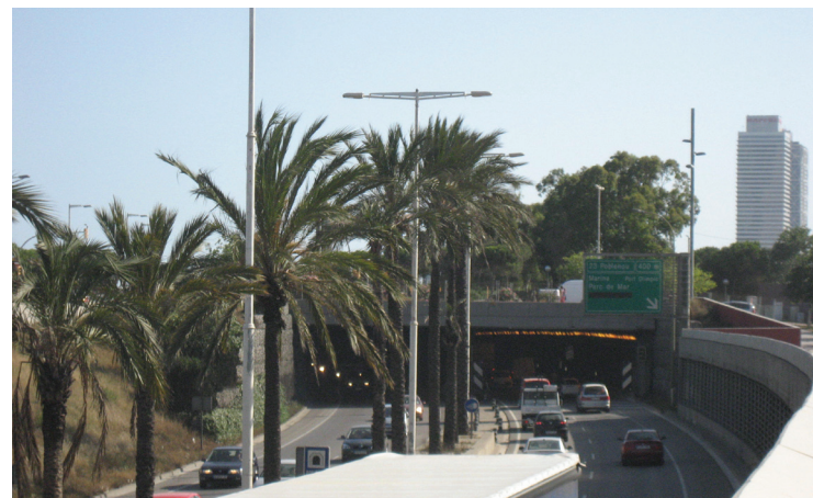
Vertikal multifunktion Parc del Poble Nou, Barcelona ligger ovanpå Avenida del Litoral och kopplar ihop staden med stranden.
