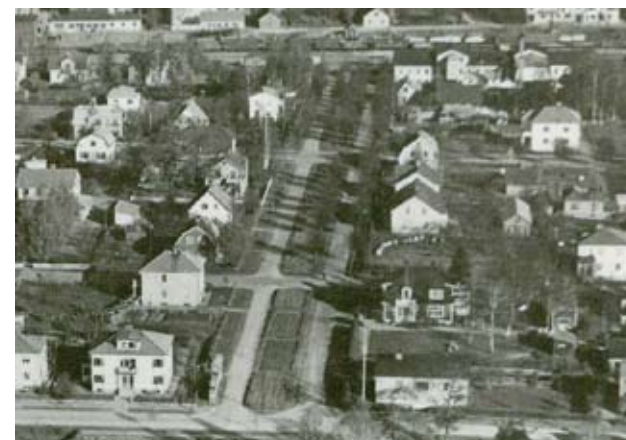
Södra Esplanaden ca 1950 visar att planteringsytan är lika lång som idag och har två motriktade körfält. Delar av den verkar dock vara uppodlad och träden har ännu inte flyttats till den tredje delen. (Vetlanda museum)
