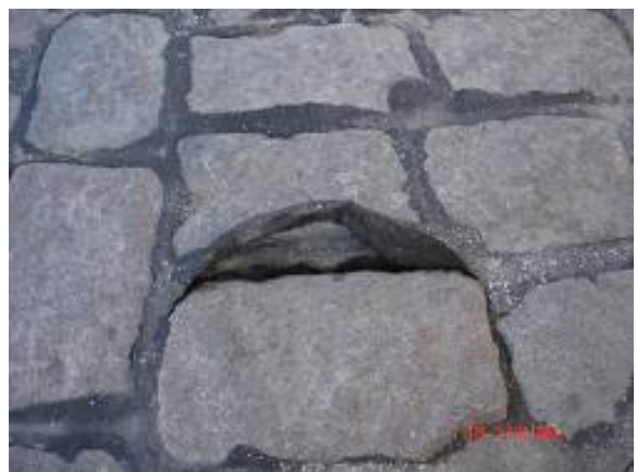
Figur 33. Bitumen som lyfts ur fogen.
