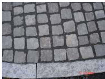
Figur 26. Nyanlagd yta, fogad med EcoFog.
