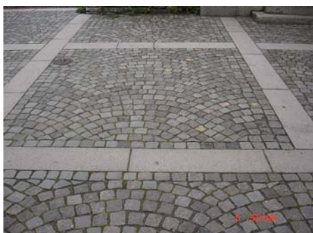
Figur 16. Läggningsmönster med granithällar och smågatsten.
