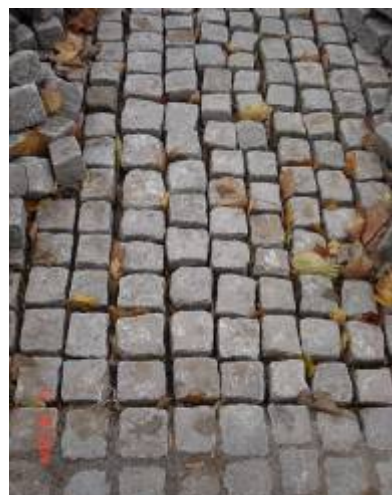
Figur 24. Så här ser det ut under pågående stensättning.
