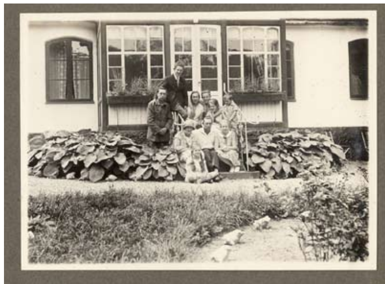
fig.14 Verandan på norrsidan av mangårdsbyggnaden. Foto från Bo Herrlöfssons samling.
