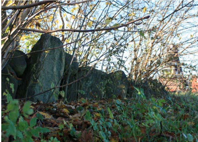
Figur 62. Stenmuren som ramat in Kvarndalas trädgård mot väster och norr åtminstone sedan 1930-talets mitt syns fortfarande tydligt efter lövfällningen på hösten. I bakgrunden till höger syns kvarnen. (Foto: Boel Persson, 2007-11-01)
