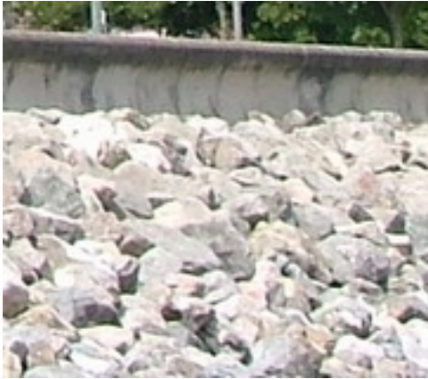
Figur 26 visar en del av stenskoningen i Minehead. Muren bakom är böjd för att förhindra att vågor stänker ner förbipasserande.
