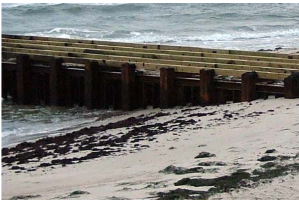
Figur 21. Närbild av hövdens stålspont.
