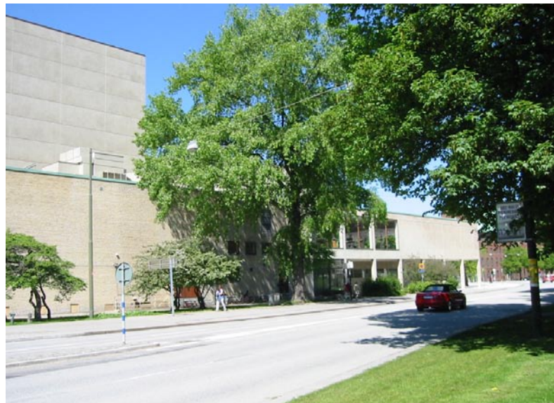
2. Pildammsvägen i norrgående riktning
