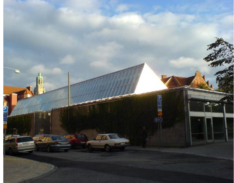
De snedställda takfönsterna sett utifrån
