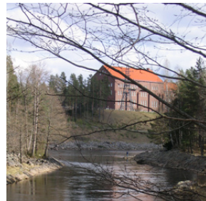
Ställverket i mörkrött tegel
