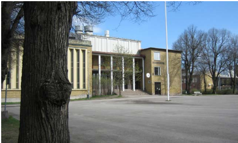
Vy Polhemsskolan i nord östlig riktning från skolgårdens nordvästra hörn
