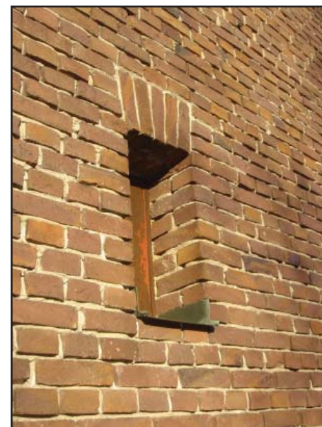
Fönsterhål i vattentornet
