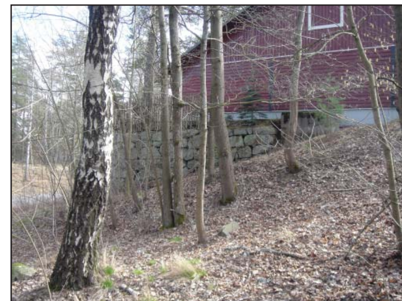
Del av muren till vattenborgen
