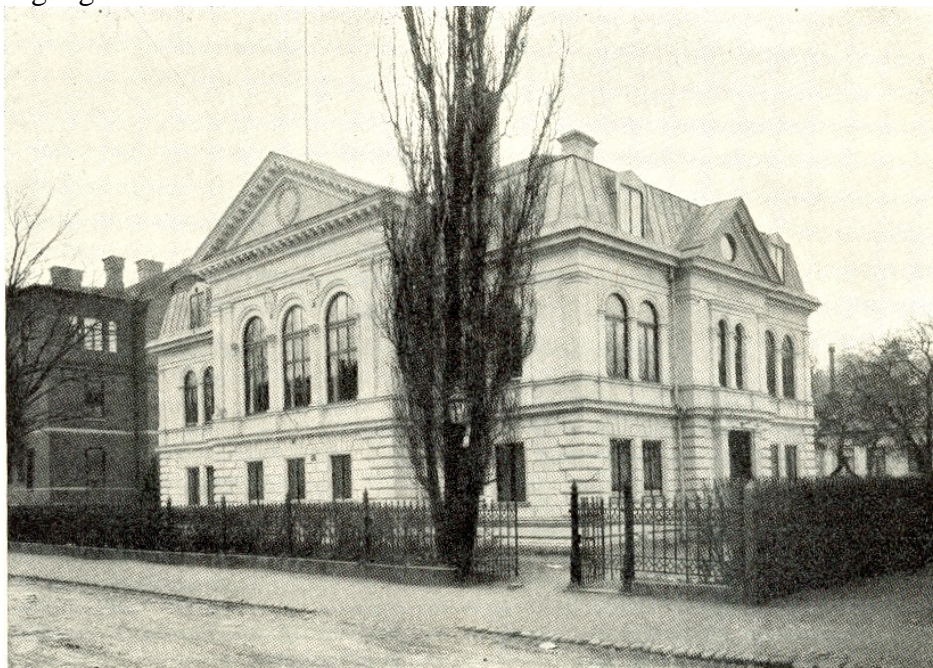
Bild 4. Nationshuset efter ombyggnaden 1912.
