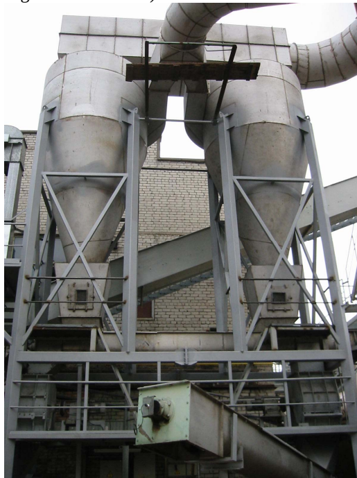
Figur 5.2 Rökgascyklonerna vid SIA Talloils fabrik
