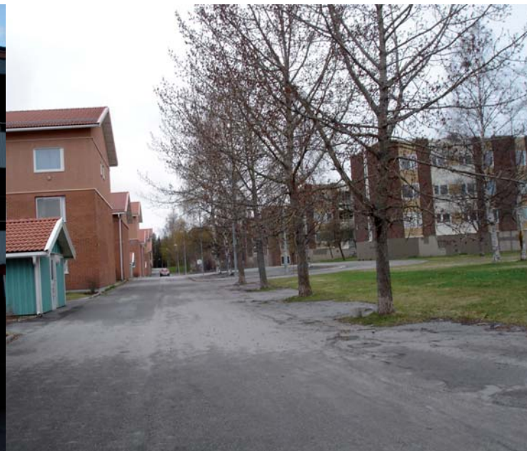
Påbyggda våningar med sadeltak, Socionomstråket västra delen.
