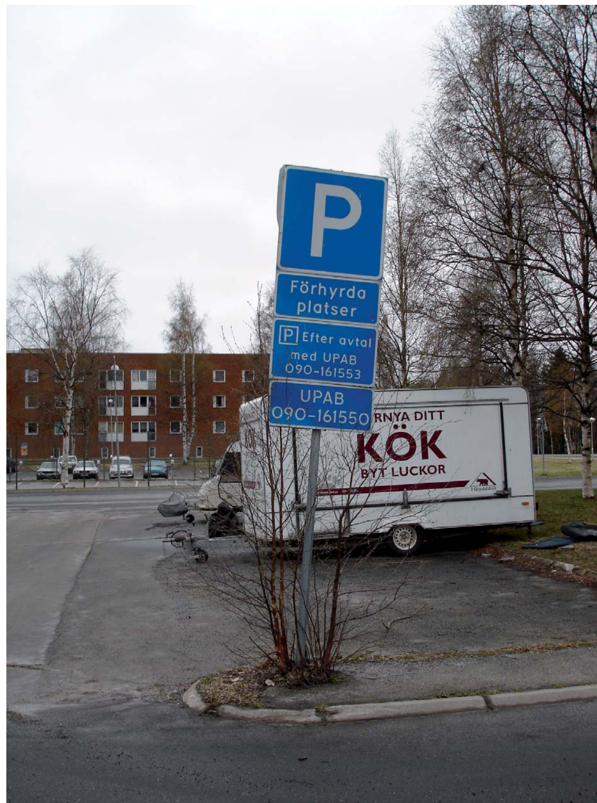
Delar av området känns slitet; ogräs växer upp ur markbeläggningen, gropar i asfaltsytor och kantsten saknas vilket visar att området skulle behöva rustas upp, Assistenvägen, Ålidhem.
