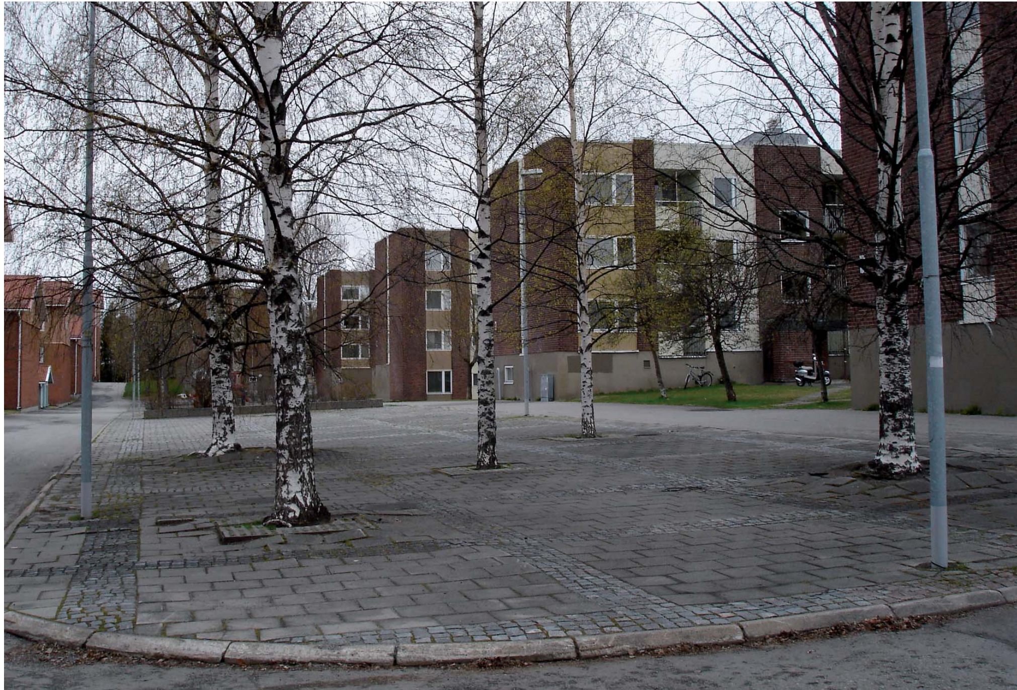
Björkarnas rötter har tryckt upp betongplattorna och förstört markbeläggningen, Socionomstråket Ålidhem.
