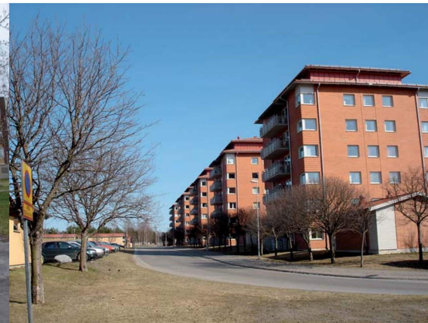
Nya femvåningshus på Magistervägen, ett försök till för- tätning av området.
