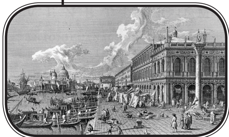
View from the piazzetta towards Canale Grande and Santa Maria della Salute.
