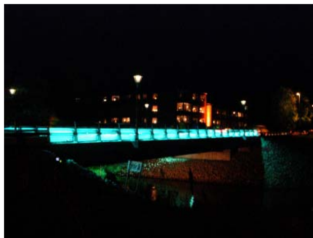
Nyebroen belystes med filterförsedda lysrör under Ljus i Alingsås 2004.
