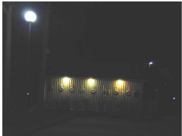
Miljöstationens belysning visar byggnaden på ett bättre sätt än vad övriga byggnaders väggfasta armaturer gör.
