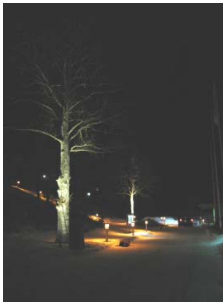
Belysningen av bokträden koncentreras till stammarna för att visa upp den silvergrå färgen. Det främre trädet är belyst med en 35 watts metallhalogenlampa, vilket passar bra.
