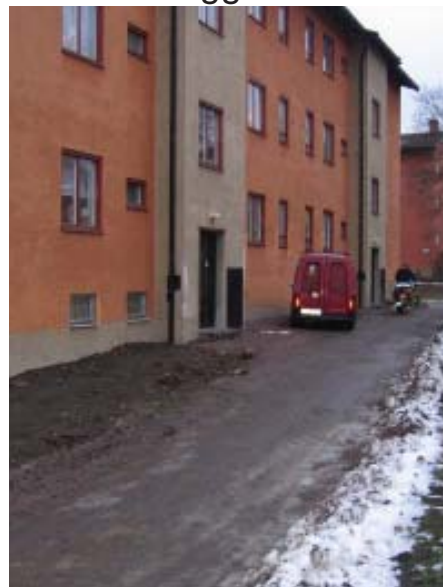
Bild 65. Entréer vid gården Brickbandet efter utförd dräneringsarbete år 2005.
