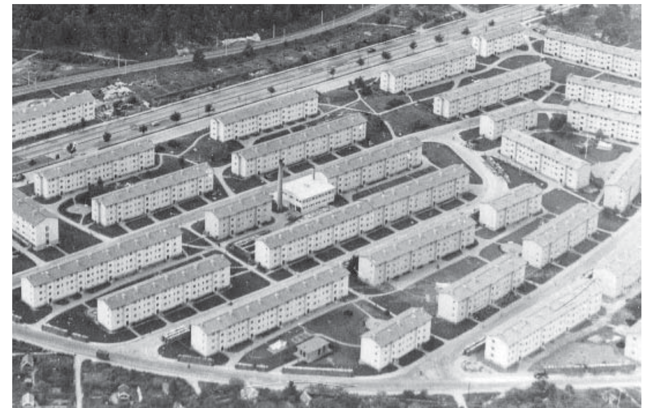
Bild 79. Denna flygbild visar tydligt Brickbandets omfattande gräs- och grönytor. De hårdgjorda ytorna utgörs endast av gångvägar, funktionsytor och entréer.
