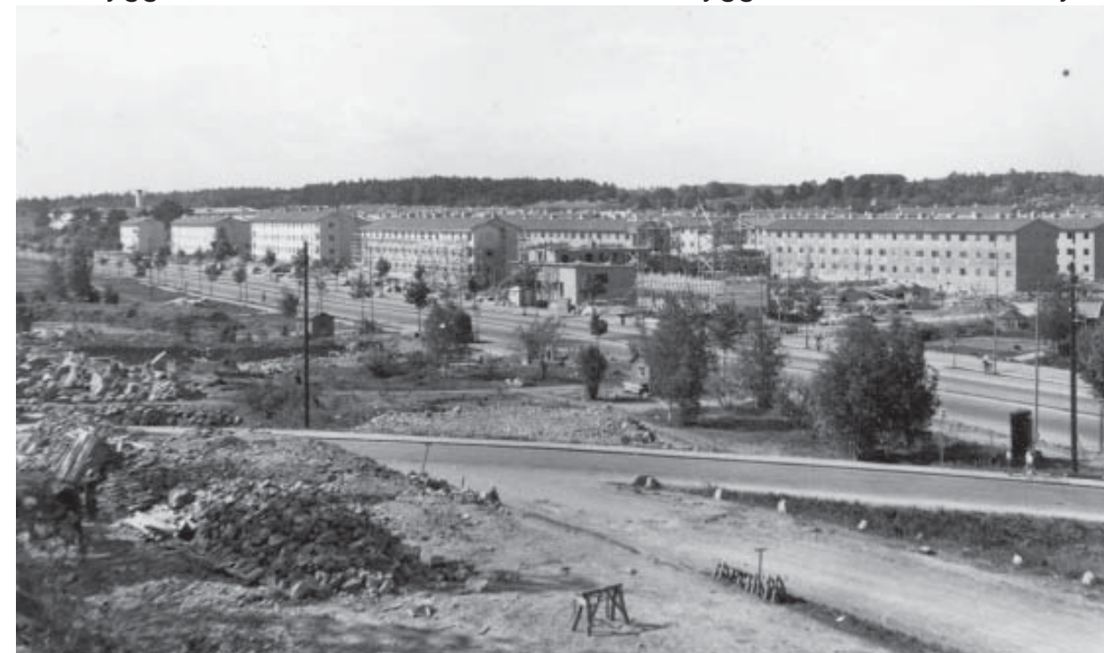
Bild 9. Brickbandet under byggnation. Odaterad bild.
