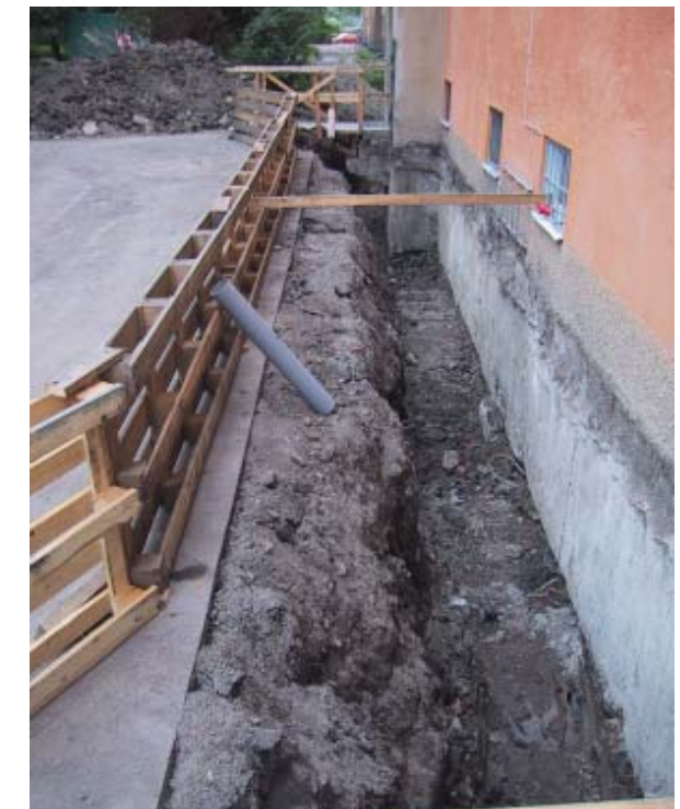
Bild 27. Pågående dräneringsarbete av husgrund, Stramaljvägen 14-20.
