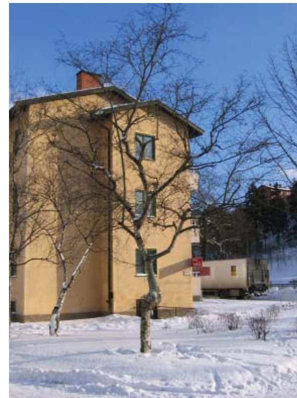
Bild 36. Dåligt klimatanpassad, ursprunglig björk vid Braskuddens västra entré
