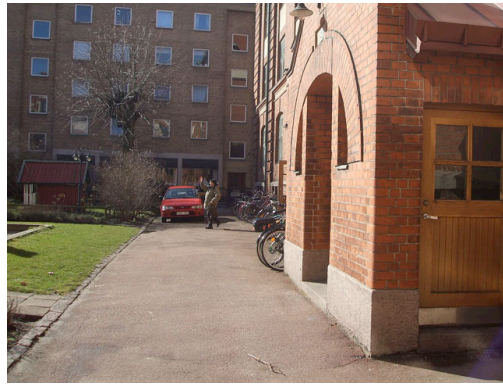
Bilar har möjlighet att ta sig fram till alla elva trappuppgångar. Entréerna är förlagda en eller tre trappor upp. Foto: Emelie Kjellberg 17 mars 2009.
