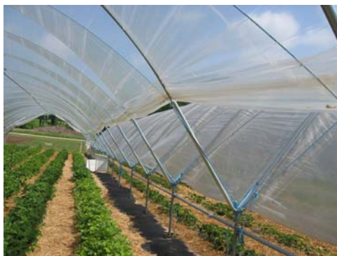
Figur 5. Tunnel som luftas.
