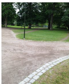
Figur 1 visar gångväg som delar sig i två riktningar utan informationsskylt med vägledning. Kantsten mellan gräsmatta och grusväg fungerar som naturligt ledstråk. Linnea Tillenius (2017-07-01).
