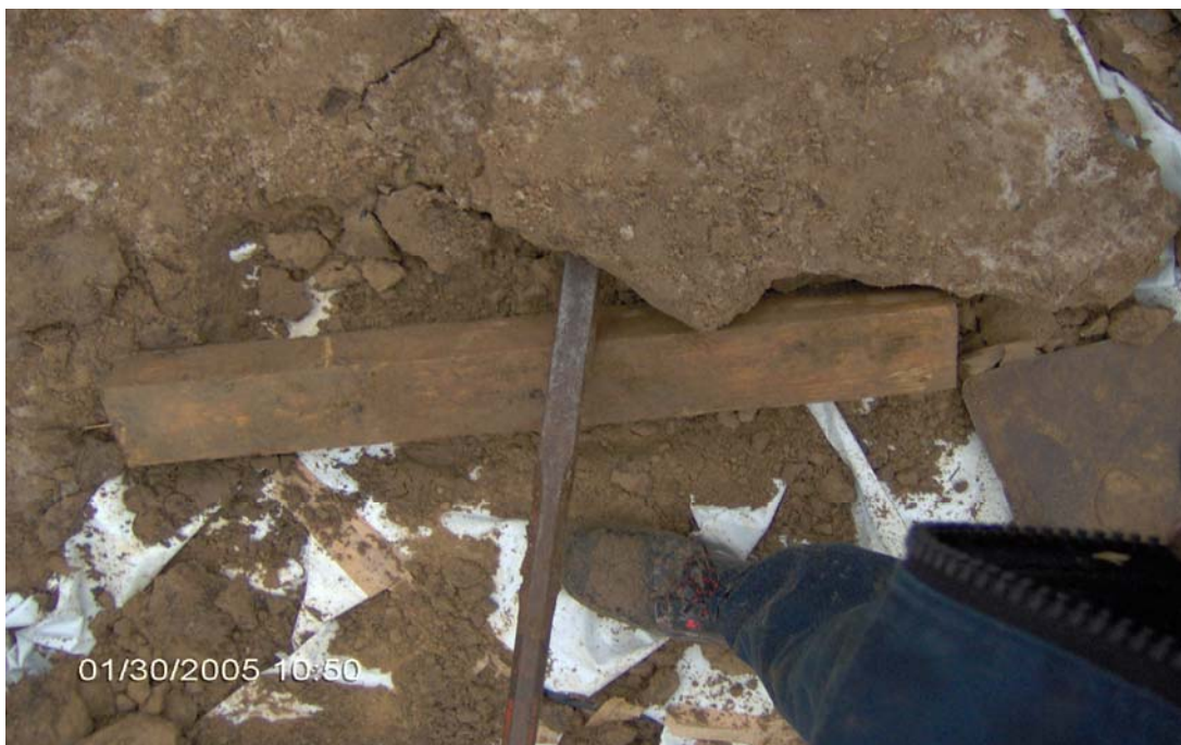
Bild 13, Öppnandet av silorna
