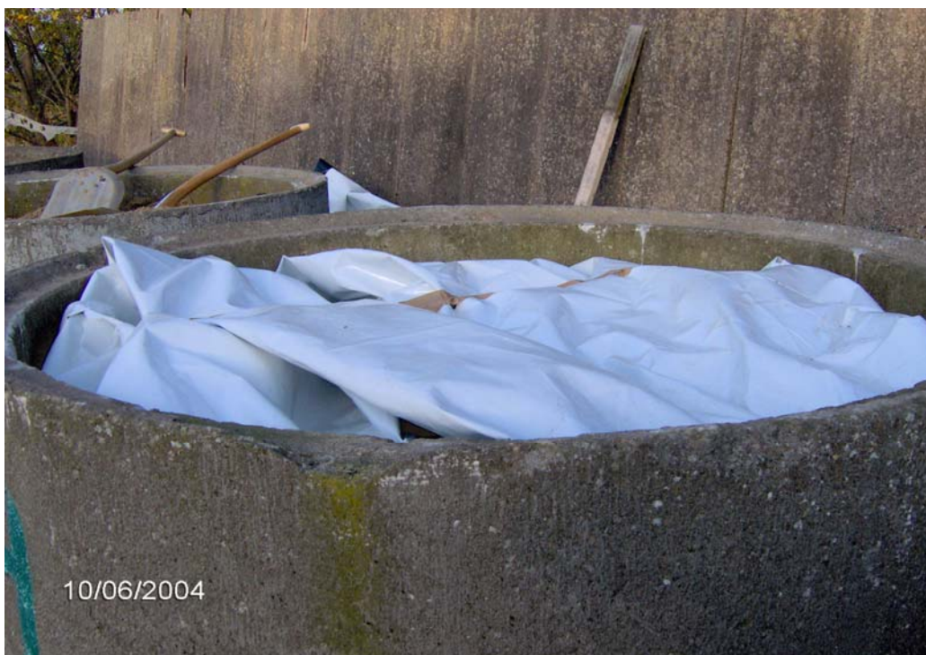
Bild 7, Täckning av silorna
