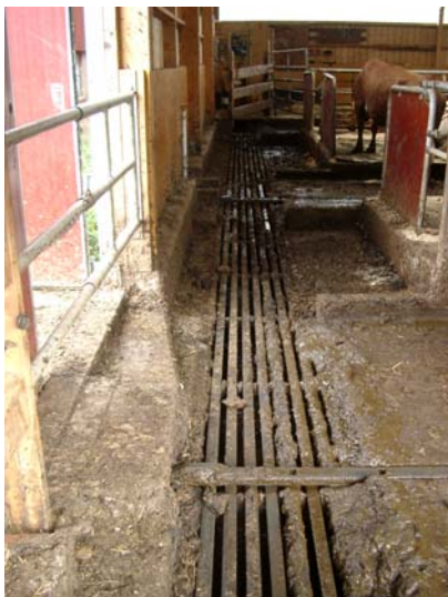
Figur 8-5 Rörligt kulvertgaller på Nilsagården.
