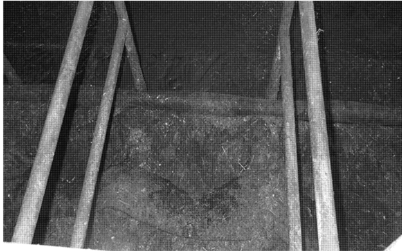
Figur 9. Fotot visar en matta som har släppts i ätbåsets framkant och foderspill har pressats in under mattan. Mattan har veckats ihop och fungerar inte tillfredsställande.
