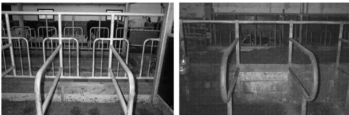
Figur 2. De två vanligaste foderbordsfronterna, till vänster fastfront och till höger nackbom.
