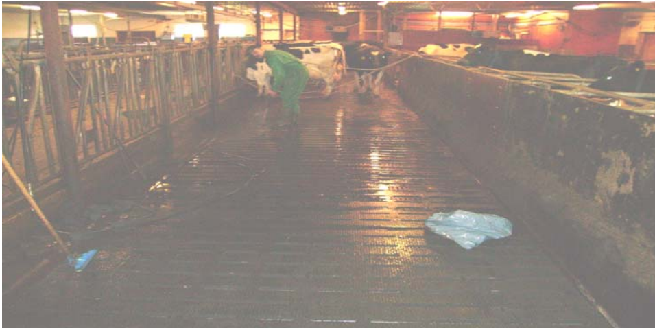
Figur 2. Inläggningen av gummimattor på gångyta längs foderbord.
