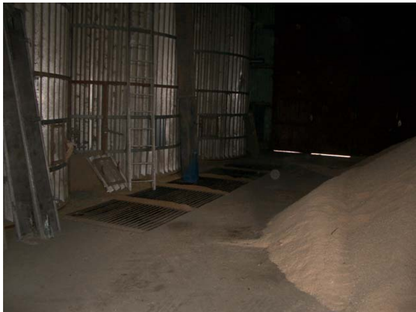
Figur 4. Tippgrop för att fylla silos som sedan ska transporteras vidare med skruv till planlager.
