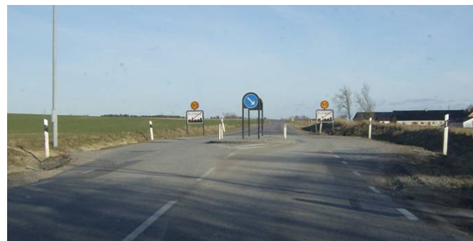
Figur 5, Sidoförskjutning i form av vägport.
