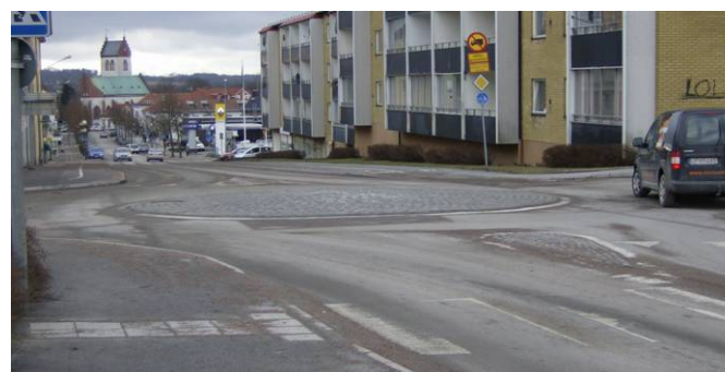
Figur 7, Överkörnings- bar rondell.
