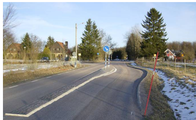
Figur 30, Förlängd mittrefug.
