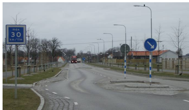
Figur 21, Tätt efter varandra följande farthinder.
