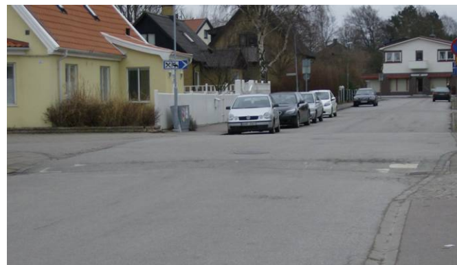
Figur 22, Dåligt utmärkt farthinder.
