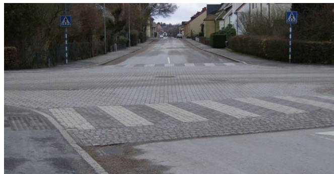
Figur 2, Platågupp i korsning med övergångsställe.
