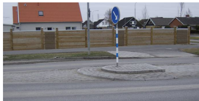
Figur 6, Delvis överkörningsbar refug.
