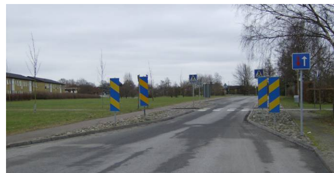
Figur 8, Avsmalning till ett körfält.
