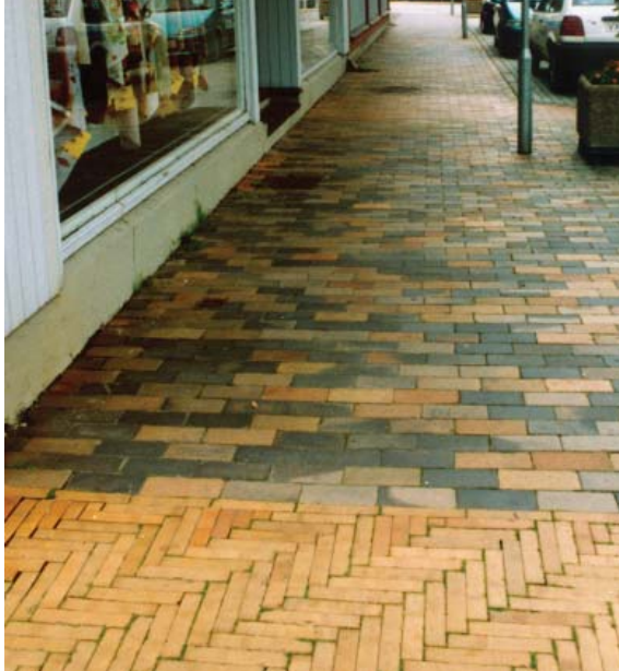
▲ Gråsten, Danmark 2004. Fiskbensmönster 90° i löpförband möter halfstens liggförband med tvärgående fogar.
