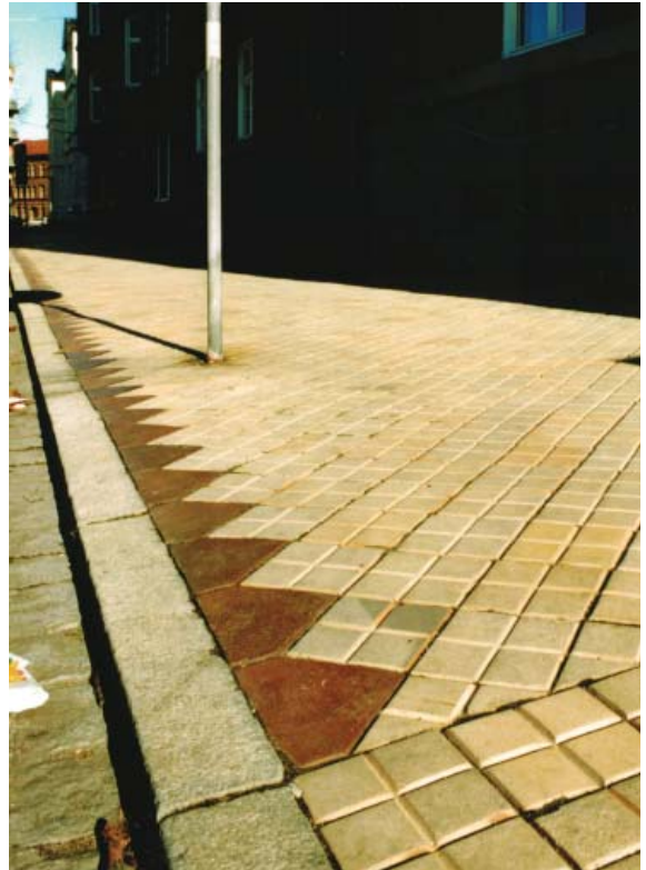
▲ Malmö 2005. Korsförband med diagonala fogar, vackert avslutade med 'biskopsmössor' i avvikande färg.
