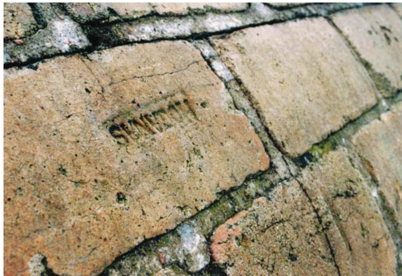
▼ Helsingborg 2004. Höganässtämplat tegel i muren vid Parapeten (stämpeln är upp-och-ner).
