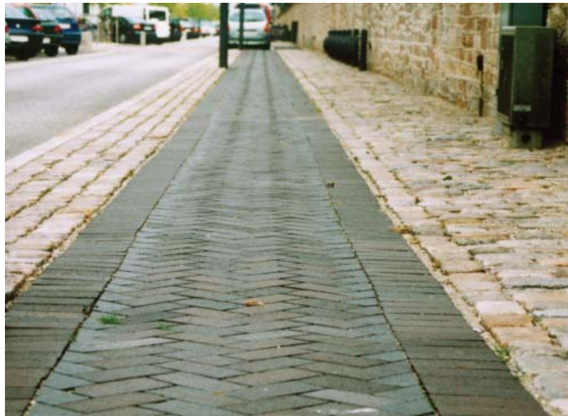
▼ Köpenhamn 2004. Fiskbensmönster 45° liggförband inramat av en rad liggande rullskift på vardera sida.
