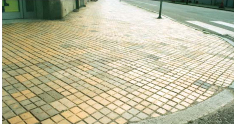
▲ Landskrona 2004. Korsförband med diagonala fogar.
