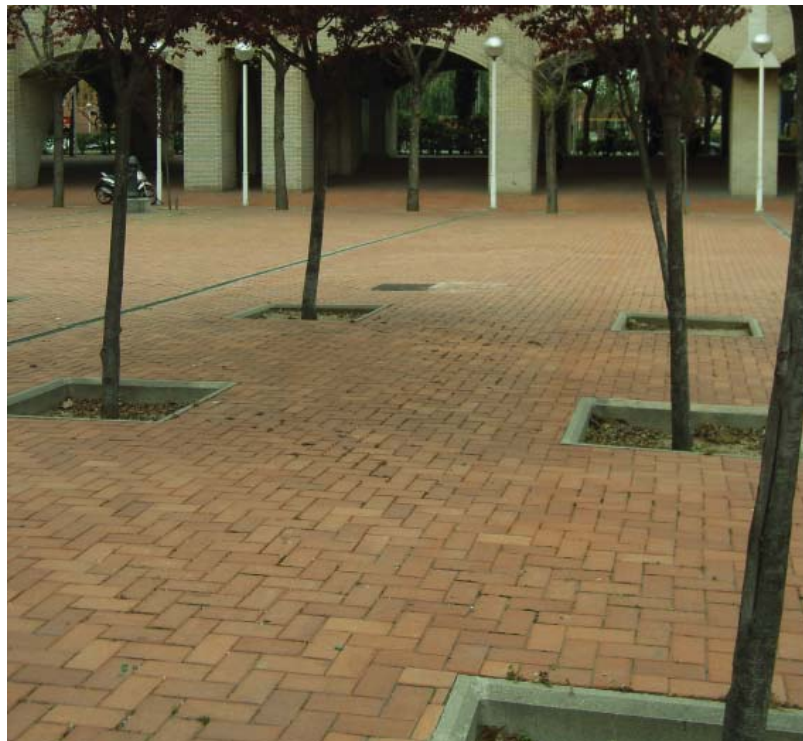
▼ Barcelona 2006. I ytan täckt med marktegel är trädgroparna nedsänkta och betongkantade. Foto Ann Bergsjö.
