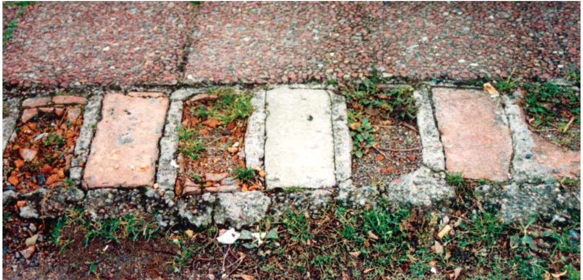
▲ Malmö 2003. Frostprängt tegel. Det här visar tydligt att det gäller att välja produkter som faktiskt är avsedda att läggas på mark!
