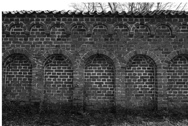
Figur 41. Muren byggdes 1850-1852 och består av minst 16 000 tegelstenar - tegelstenar som en gång brändes i det egna tegelbruket. Murens västra sida.
