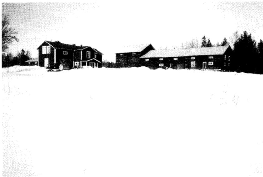
Figur 20. Foto över Jonas Åströms hem, taget år 2000. Mangårdsbyggnaden nyuppfördes i början på 1900-talet. Byggnaden till höger inrymde ladugård och loge. Foto: Lena Sandberg, april 2000.
