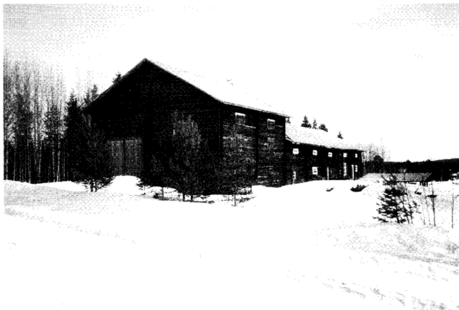
Figur 33. Jonas Åströms ladugård och loge. Den låga delen av byggnaden var ladugård och den höga delen loge. På loftet fanns våningssängar där tillfälligt anställda sov under sommaren. Foto: Lena Sandberg, april 2000.
